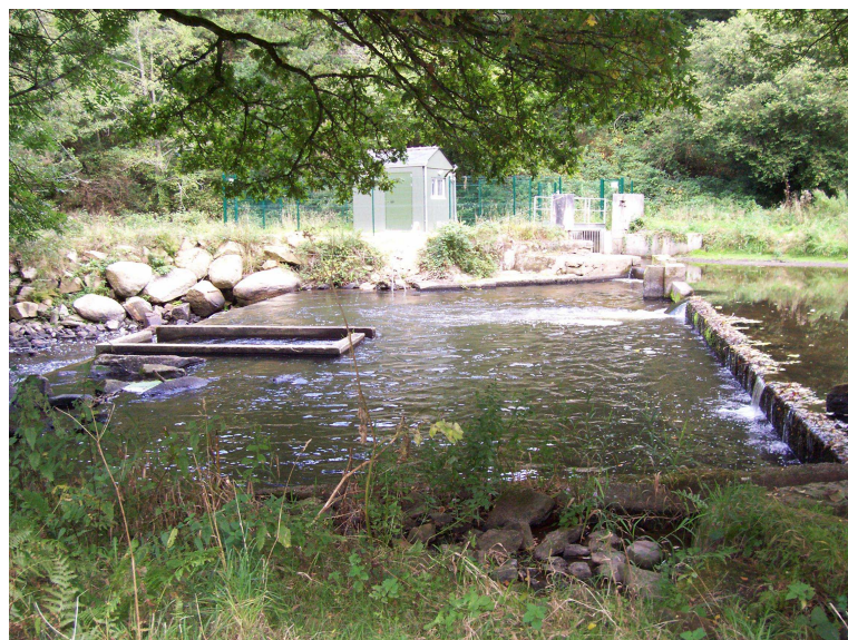
Figure 1-1 : Vues de la prise d'eau actuelle
